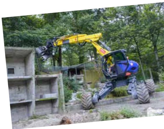
Abriss der alten Volieren
