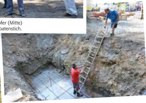
Die ersten Fundamente werden erstellt.
