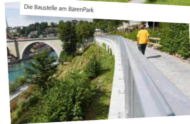
Die Sanierung der Mauer ist abgeschlossen.
