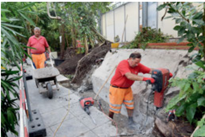
Der Bau der neuen Anlage läuft
