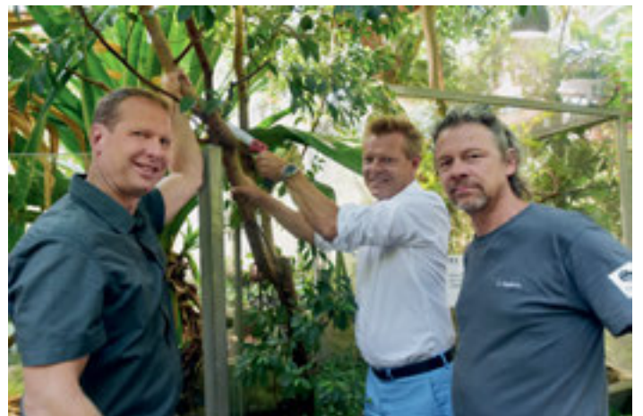
Stefan Flückiger, Reto Nause, Jürg Hadorn beim «Spatenstich» zum Baubeginn
