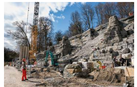
Die Betonspritzarbeiten sind abgeschlossen.
