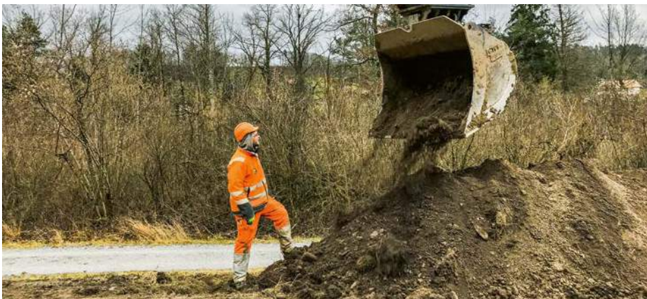
Reptiliensuche im Aushub durch Umweltbaubegleitung.
