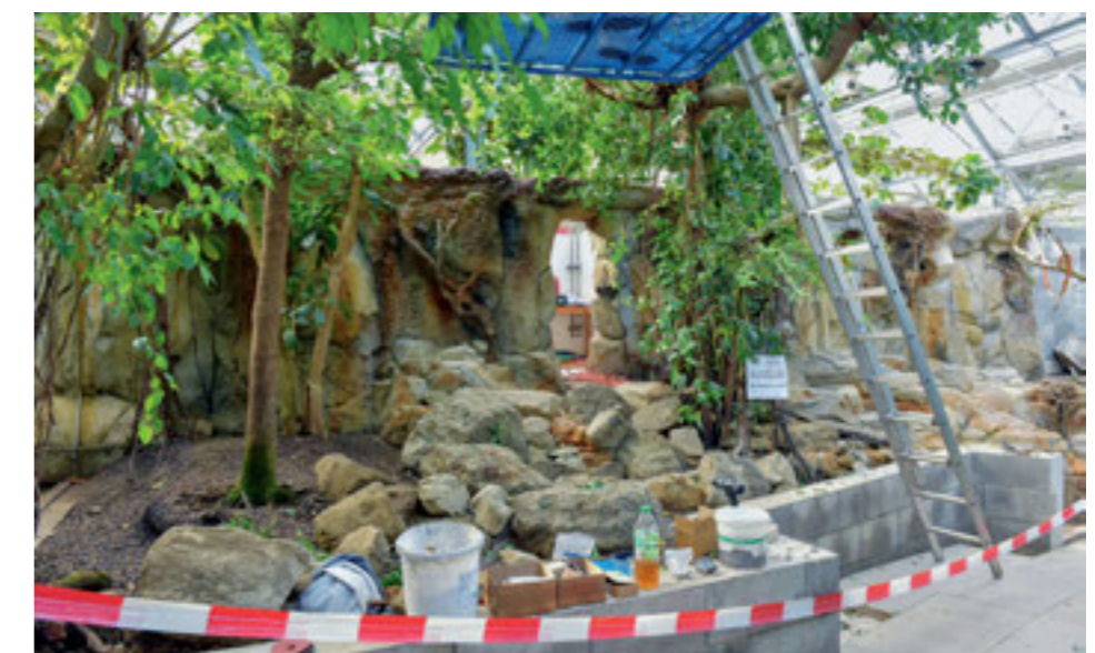
Die Baustelle im November, Rückwand und grosse Pflanzen stehen
