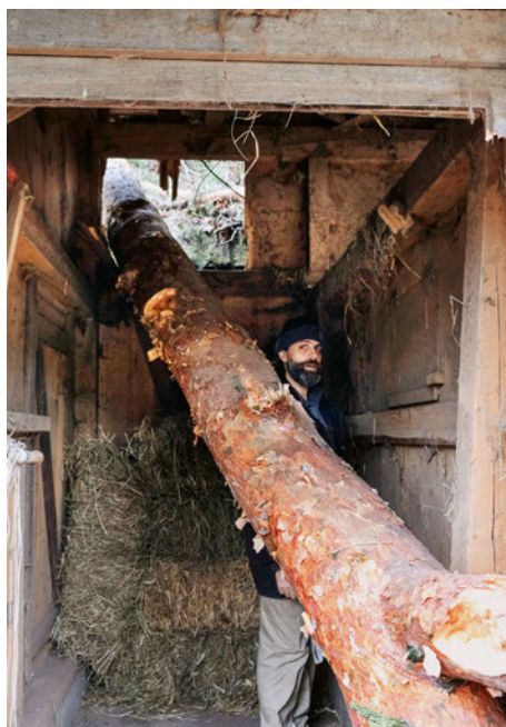
Der Stall der Wildschweine wurde von einer Föhre perforiert.
