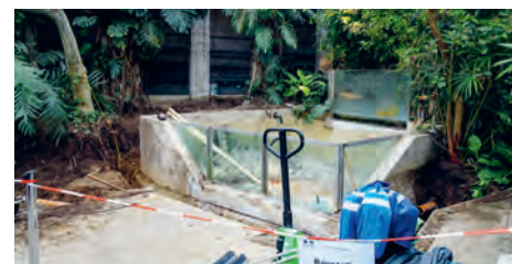
Krokodilanlage im Umbau
