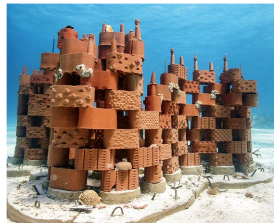
Ein künstliches Riff ist aus modularen Riffbausteinen zusammengesetzt (Foto: Leila Tazi).
