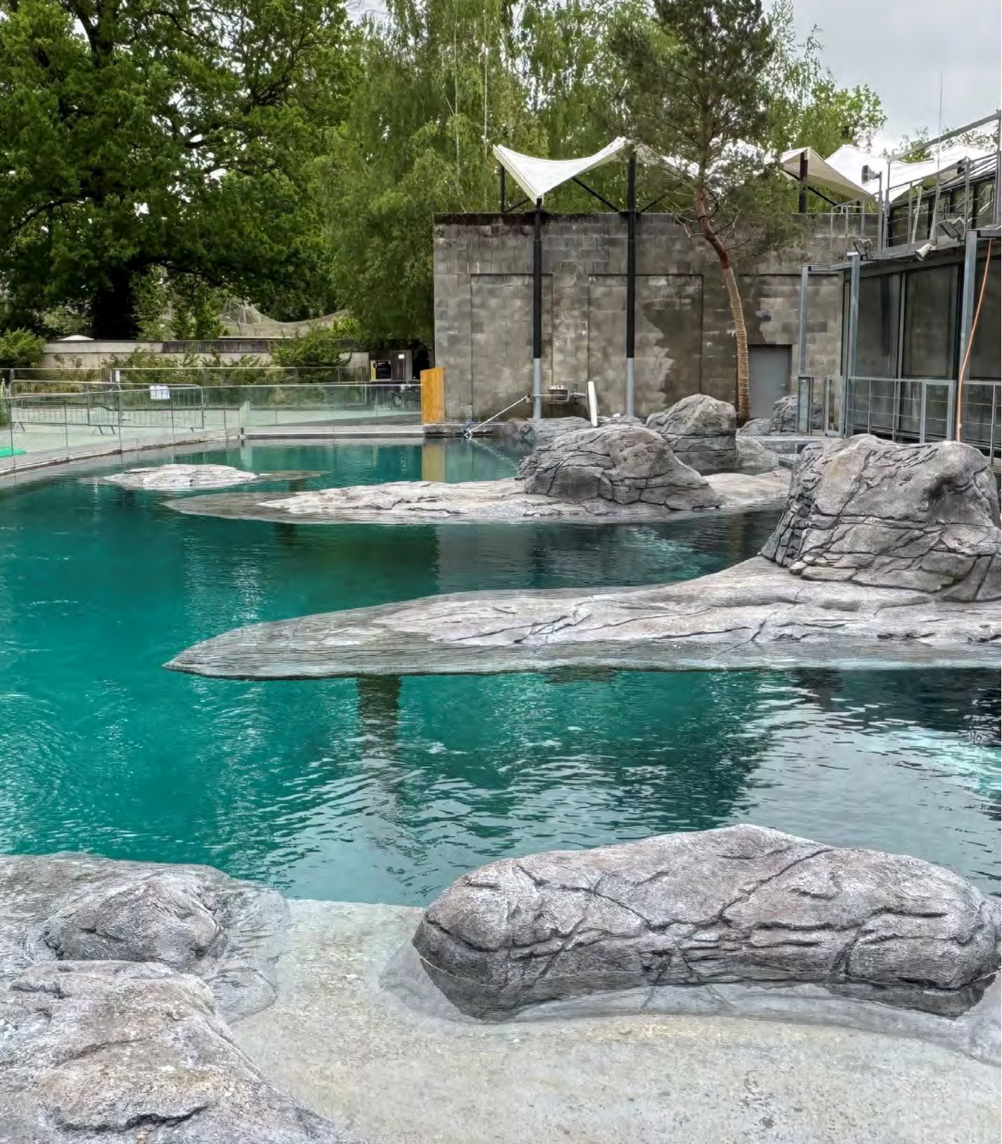
Der neue Seehundfjord mit der abwechslungsreichen Unterwasserwelt kurz vor der Fertigstellung.
